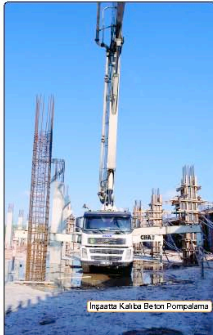
İnşaat Kalıba Beton Pompalama
